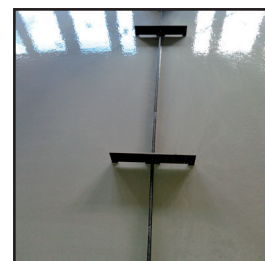
Ook tijdens het gieten blijven de profielen strak staan en hun positie behouden.
