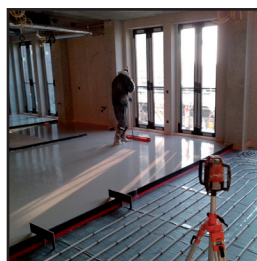
Ook tijdens het gieten blijven de profielen strak staan en hun positie behouden.
