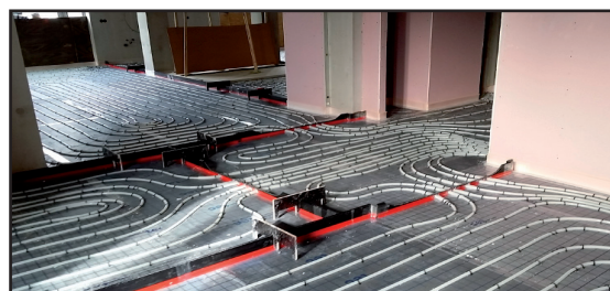
Antikantelsteunen geplaatst voor het gieten.
