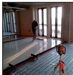
Redumax tape en Redumax Dilatatiesysteem op AkoestiTACK.
