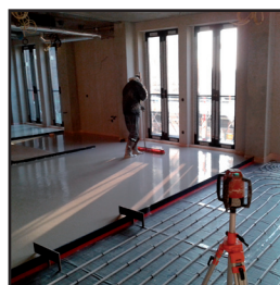
Redumax Dilatatiesysteem op AkoestiTACK.
